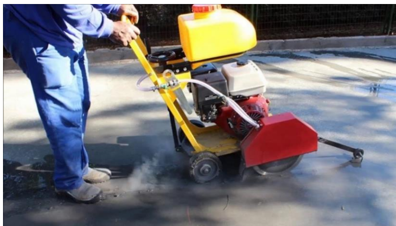
Figura 6 - Execução do corte
