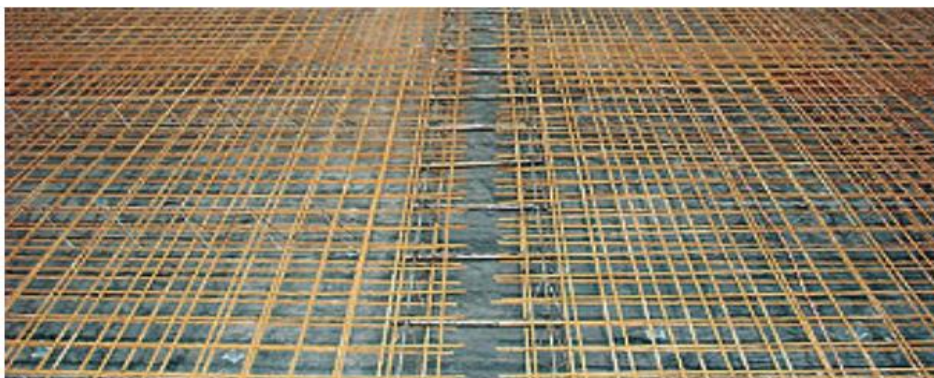
Figura 2 - Representação da barra de transferência com a telas separadas
