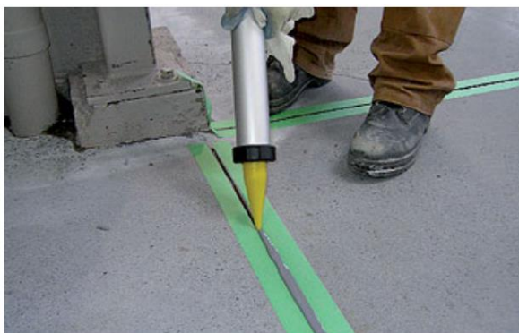
Figura 8 - Representação da aplicação do selante com fita de proteção
