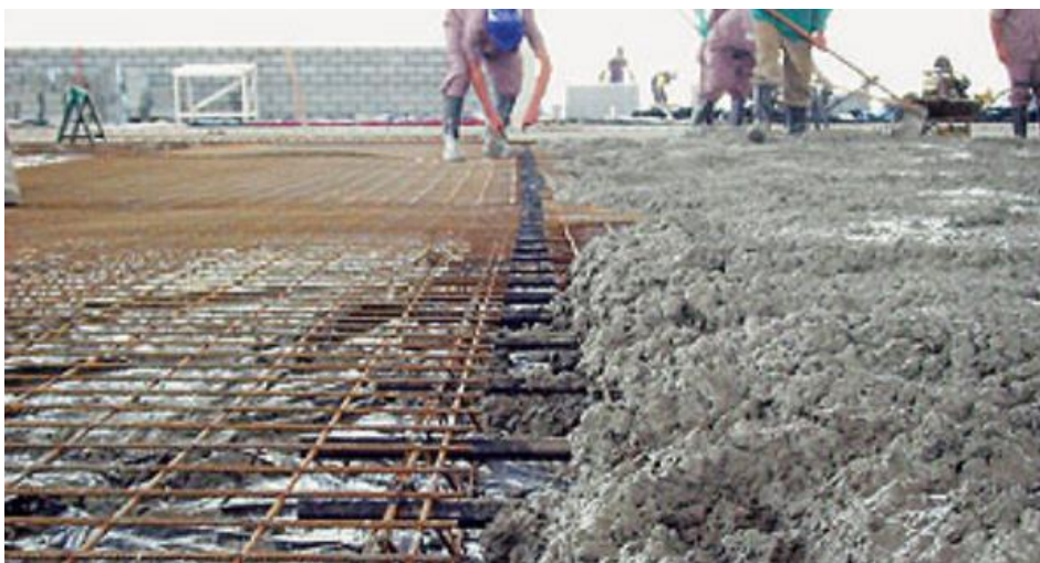
Figura 3 - Representação da barra de transferência durante a concretagem
